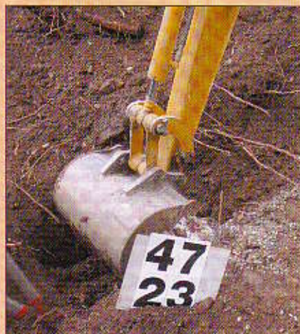
2 Il taglio delle radici a diverse distanze viene effettuato con l'ausilio di un escavatore.
